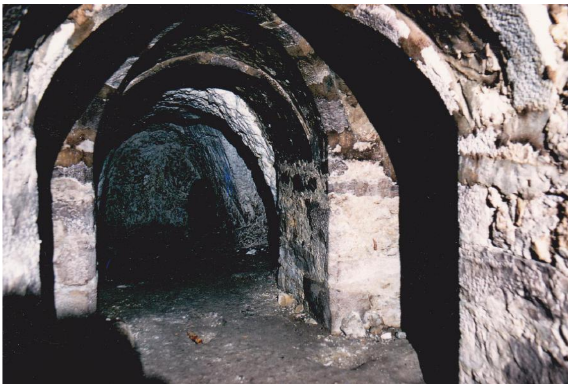
Vue du second niveau, voûte sur croisée d'ogives et alvéoles creusés dans le calcaire
