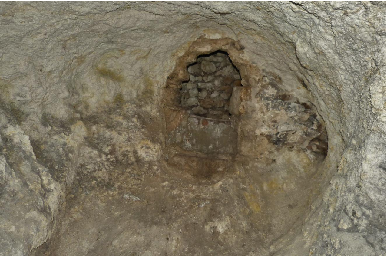
Alvéole ouest menant au puits, au fond on aperçoit le cuvelage de pierre.
