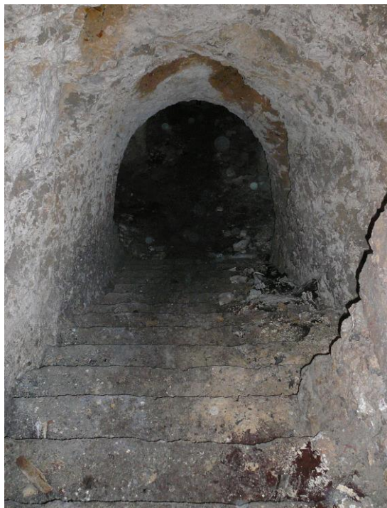
Galerie de descente d'escalier
